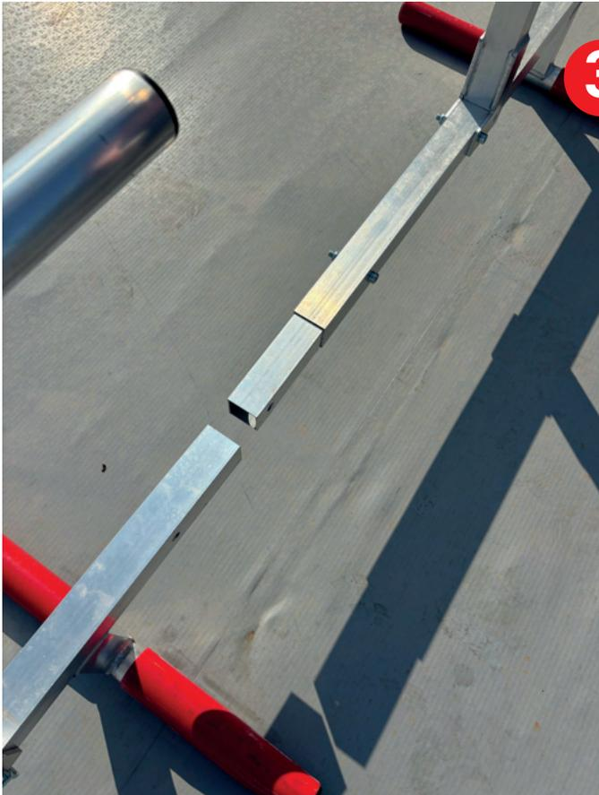
Die Gitter können miteinander verbunden werden indem Sie die Gitter zusammen schieben. Sichern Sie die Gitter mit dem beiliegenden Sicherungsstift.
